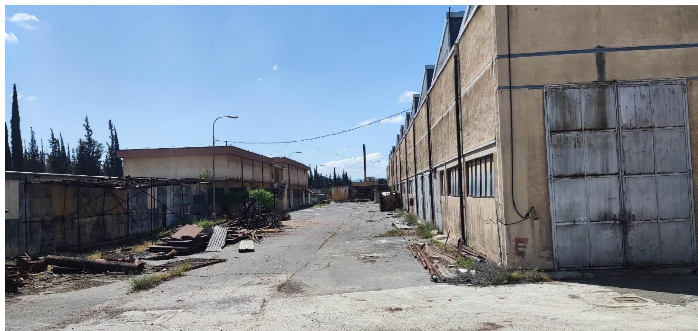
کارگاه تعمیرات موتورها، لوله های آب قالبها، لوازم برقی، تجهیزات مکانیکی
