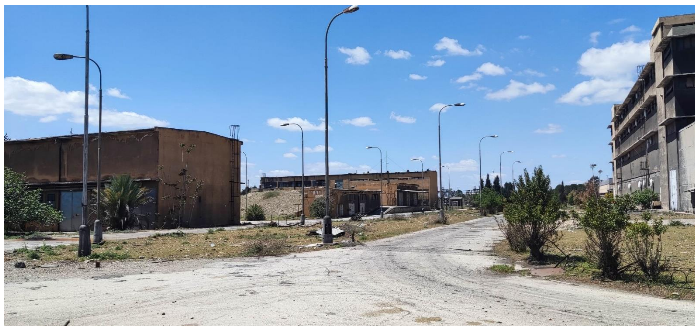
ساختمان انبار روغن های عطری، گرم کردن روغن عطری و ایستگاه هوای فشرده
